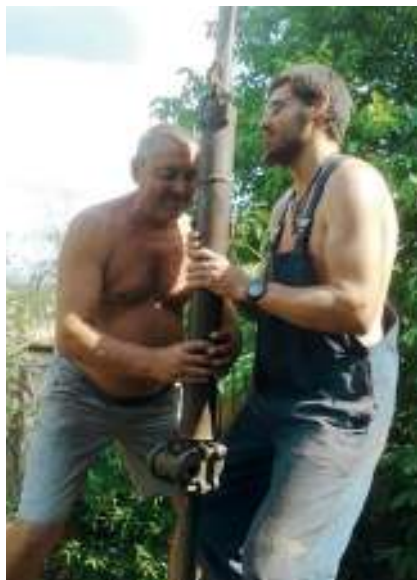
Silou paží prorážíme trubku na spodní vodu – tak se na Zakarpatí staví pumpy
